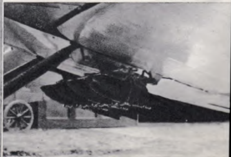
Hieronder: een C V vliegtuig uitgerust met vier mijnbommen van 25 kg. Duidelijk ziet men de wijze waarop de bommen zijn bevestigd.
