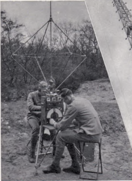
Hierboven: het nieuwste type van een Yeldpeiler voor het peilen van vliegtuigen, wordt bediend. Rechts: een radioxrust op Soesterberg. Rechts boven: peilraam op het vaste radiopeilstation te Soesterberg.
