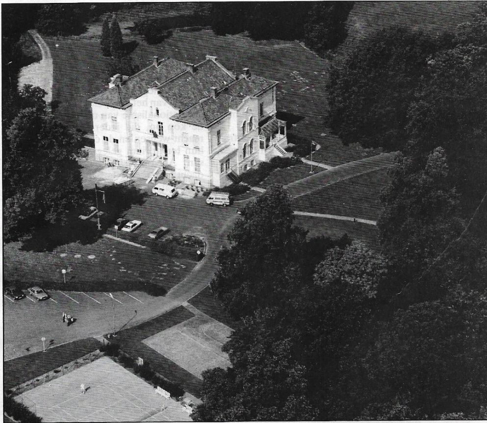
De villa van CTL: markant licht- machtinggebouw (foto: Fotovlucht)
